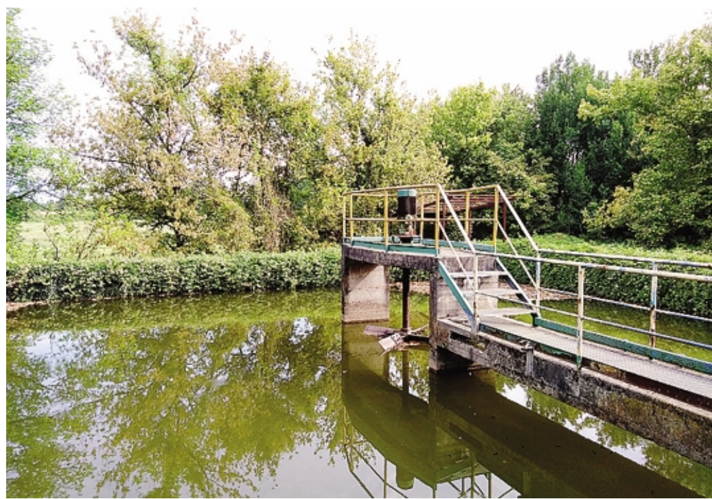
L'ex depuratore di Boltiere diventerà un'aula all'aperto
