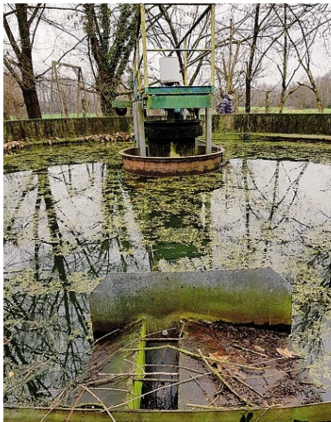
L'impianto di depurazione dismesso a Boltiere
